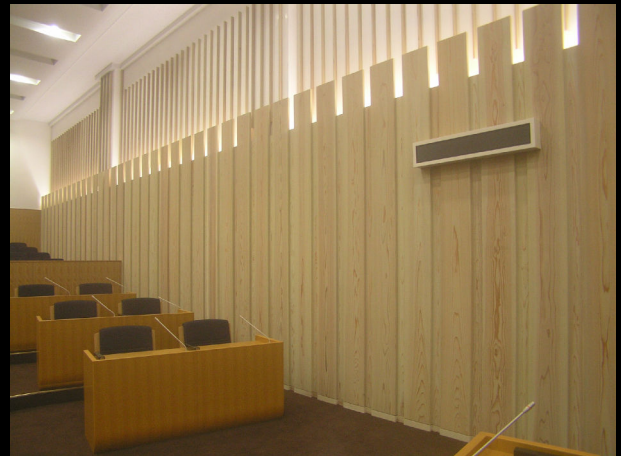
宍粟市新庁舎 議場不燃壁
