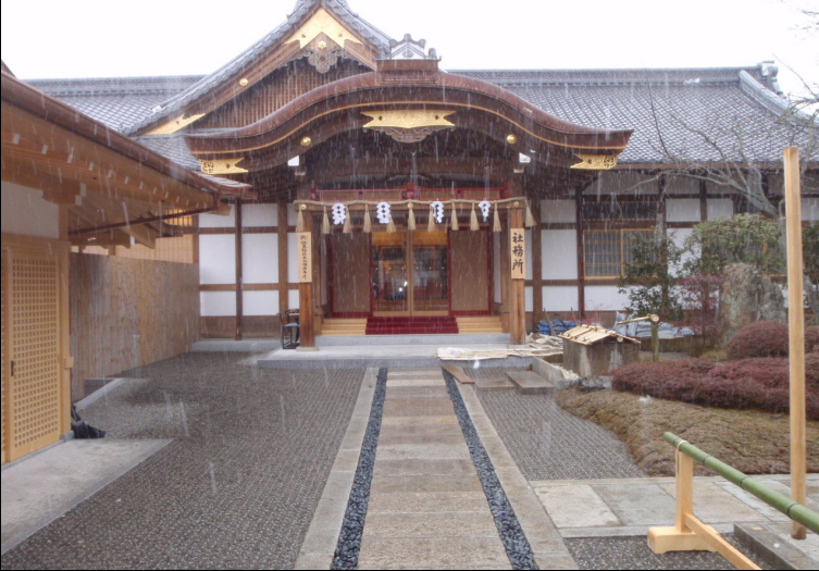
伏見稲荷大社 社務所 外観
