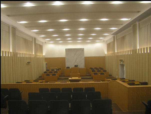
宍粟市新庁舎 議場不燃壁
