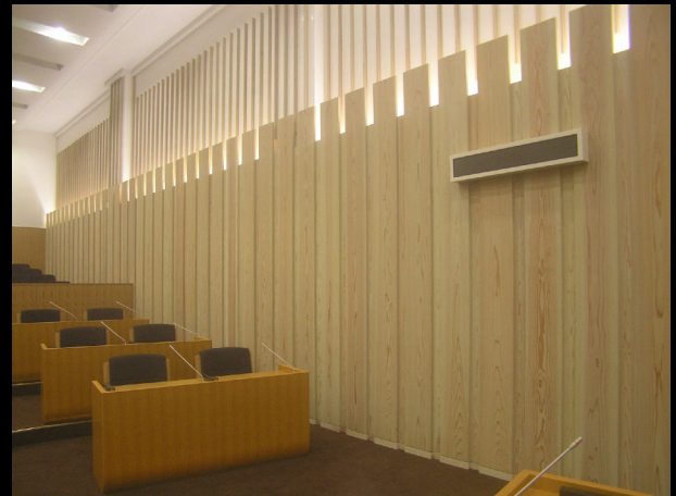
宍粟市新庁舎 議場不燃壁
