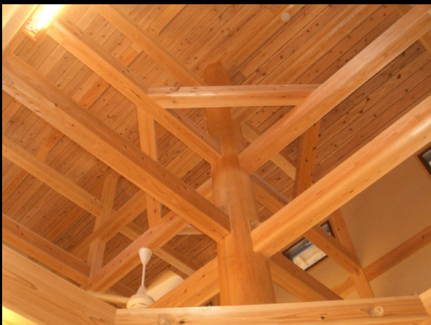
北賀茂地区交流施設
