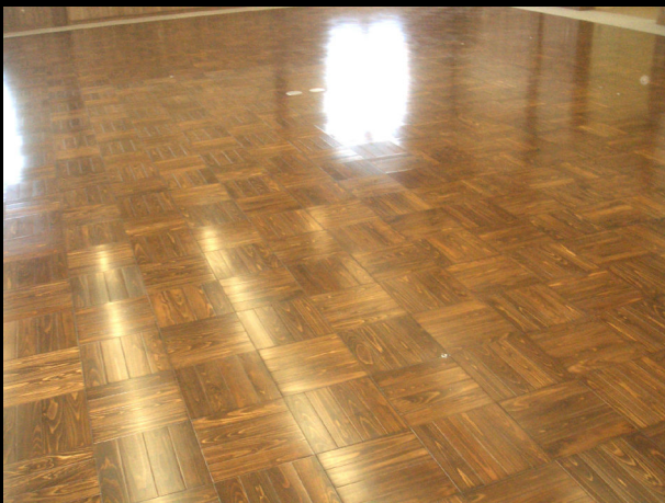
いなみ野学園中教室棟 檜蔵張り
