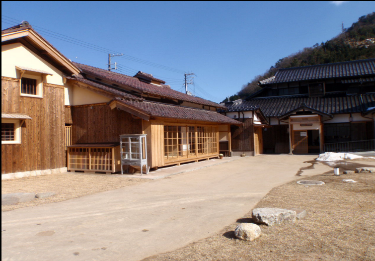
银山町ミュージアムセンター 外観
