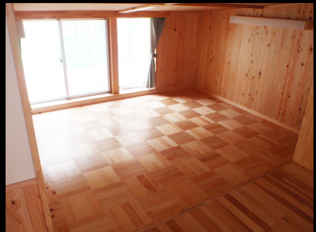
キッズランドかみB棟 檜蔵張り
