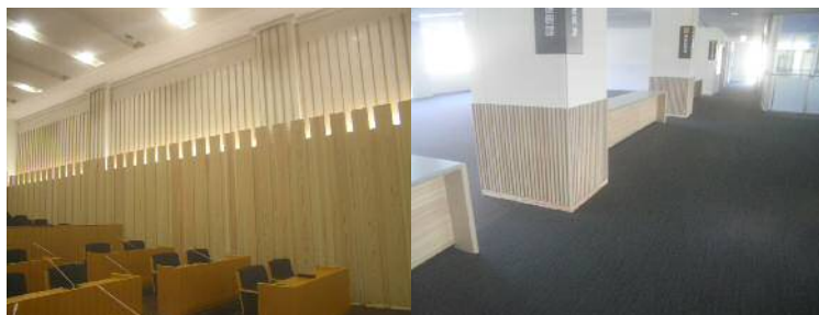
難燃処理材施工例
