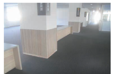
準不燃処理材施工例
