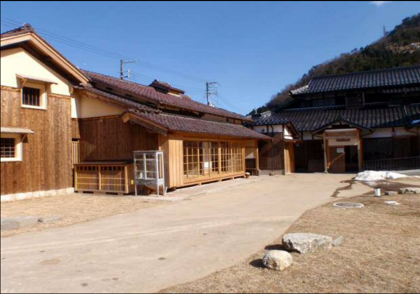
銀山町ミュージアムセンター 外観
