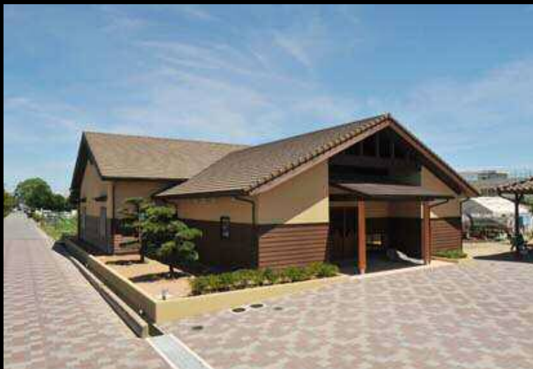
いなみ野学園中教室棟 外観
