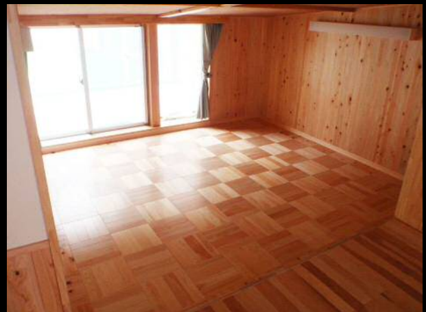
キッズランドかみB棟 檜蔵張り
