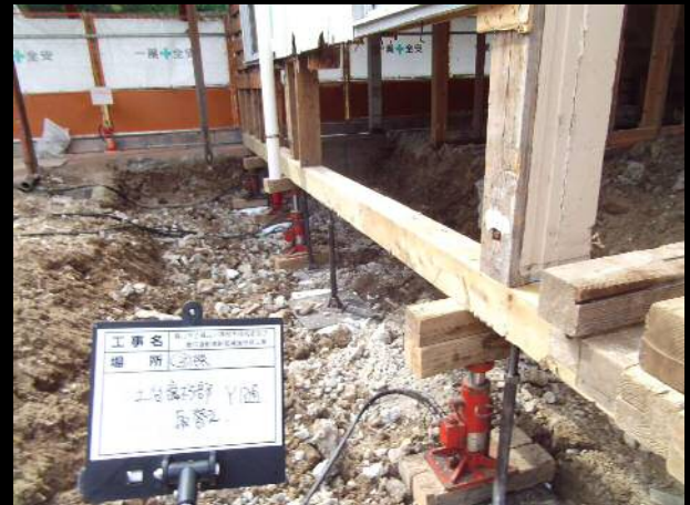
腐朽部 改修後
