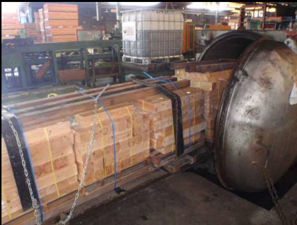
防腐剤注入状況
