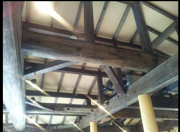
風呂場屋根:手刻み加工
